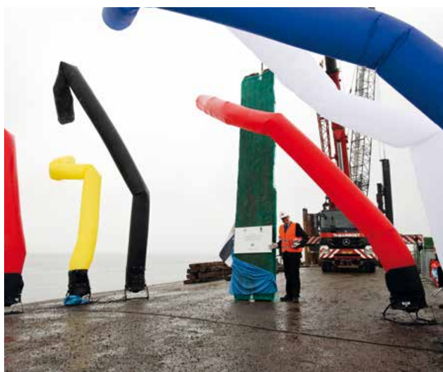
Commissaris van de Koning Han Polman gaf op 27 mei het startsein voor de bouw van de 115 meter hoge toren
